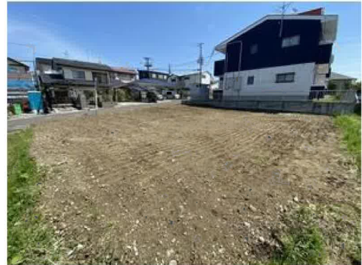
敷地内南西側より撮影
